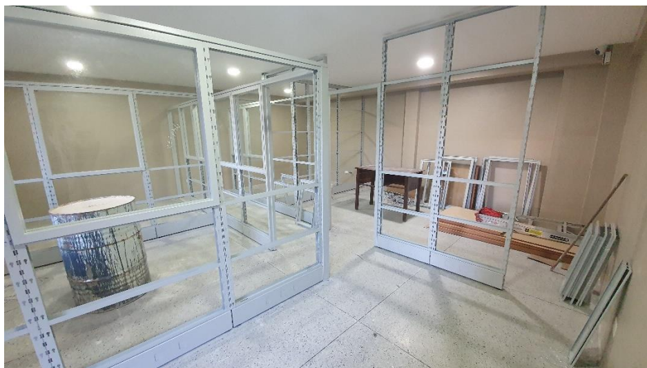
Ilustración 43 Instalación de divisiones para Oficinas de Coordinación Fuente: Ing. Bryan Logacho Responsable de Obras Civiles
