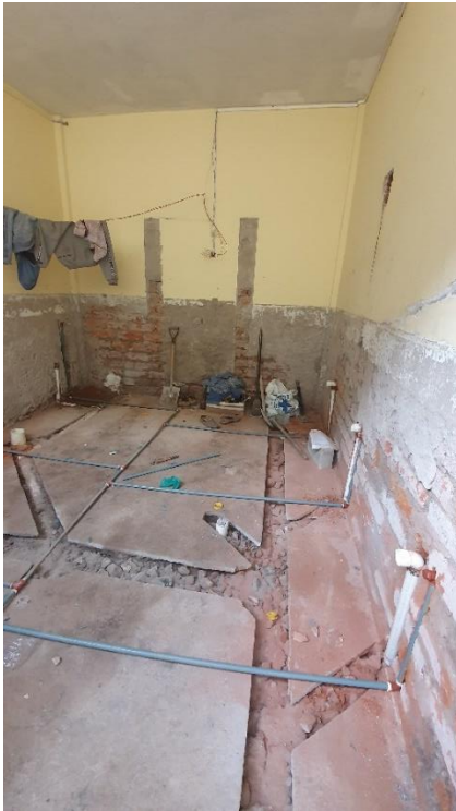
Ilustración 44 Construcción de baño de mujeres Fuente: Ing. Bryan Logacho Responsable de Obras Civiles
