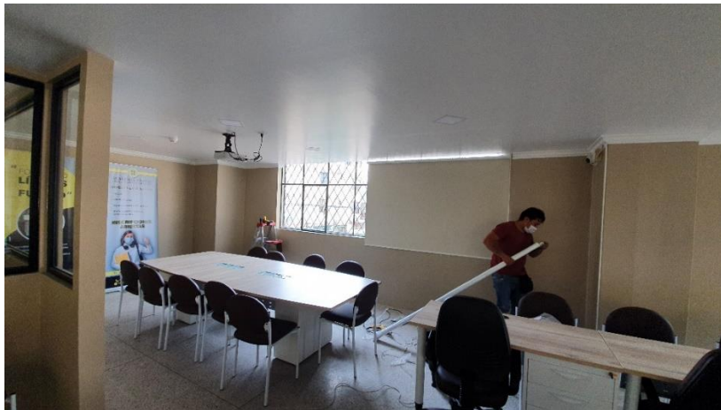
Ilustración 40 Instalación de cortinas en sala de profesores Fuente: Ing. Bryan Logacho Responsable de Obras Cívicas
