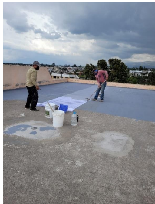
Ilustración 45 Impermeabilización de terraza con malla y pintura Fuente: Ing. Bryan Logacho Responsable de Obras Civiles
