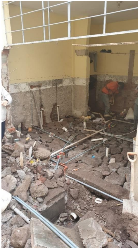
Ilustración 42 Readecuación baño de hombres Fuente: Ing. Bryan Logacho Responsable de Obras Civiles
